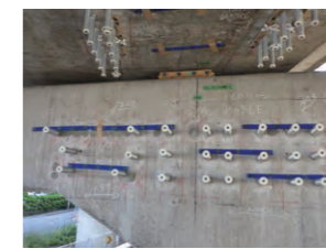
アンカーボルト座標測定
