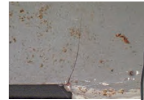
鉄骨部材亀裂状況
