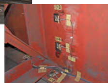
ひずみゲージ設置状況
