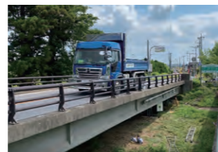
道路橋沈下計測
