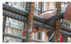
熱電対設置状況
